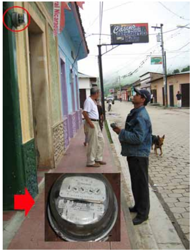
Fotografía tomada en Quilalí, mientras un funcionario de Unión FENOSA hace la lectura del consumo del contador, a simple vista. Cómo se puede ver en el detalle que muestra la fotografía, para cada dígito del lector, hay una manecilla pequeña. ¿Cuántos errores de lectura al día pueden darse?
